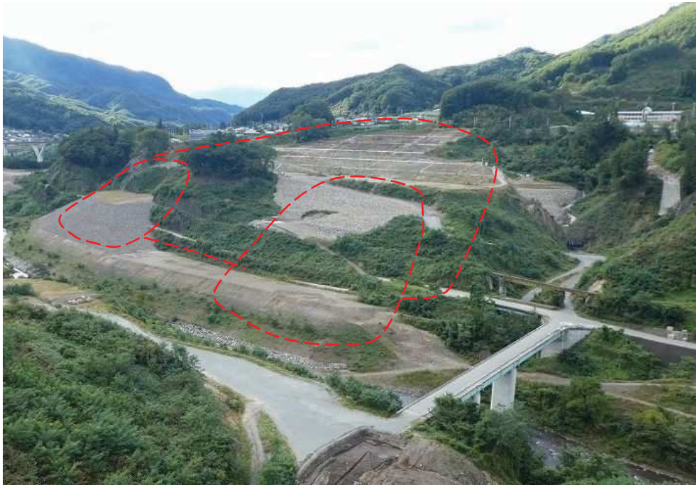
図 4.25 勝沼地区（L32）全景（湛水前状況：2019 年 9 月撮影）
