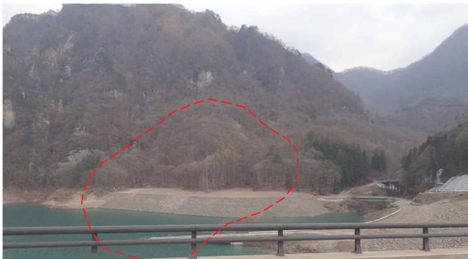
図 4.62 白岩沢地区（R12）全景（湛水後状況：2020 年 4 月撮影）
