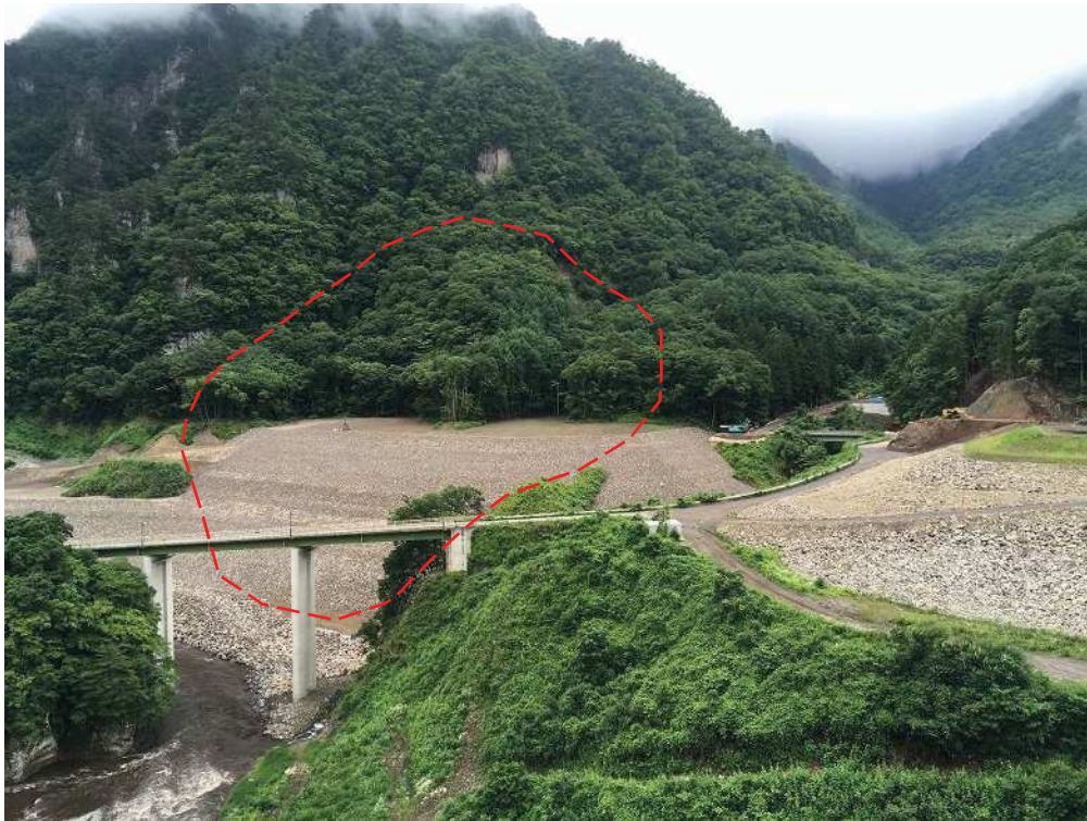
図 4.61 白岩沢地区（R12）全景（湛水前状況：2019 年 9 月撮影）
