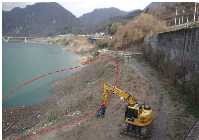
図 4.89 横壁小倉地区（R22）全景（湛水後状況：2020 年 4 月撮影）
