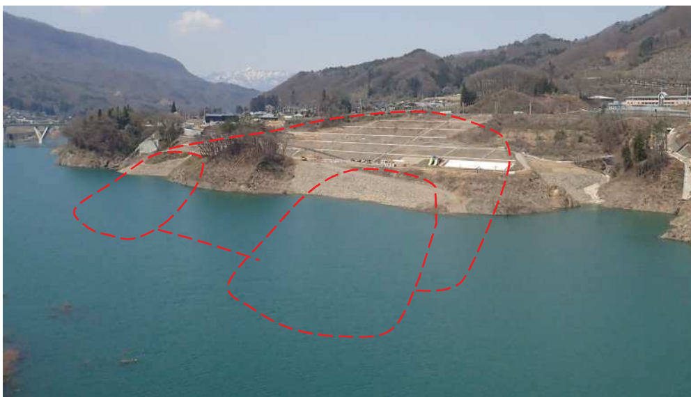
図 4.26 勝沼地区（L32）全景（湛水後状況：2020 年 4 月撮影）
