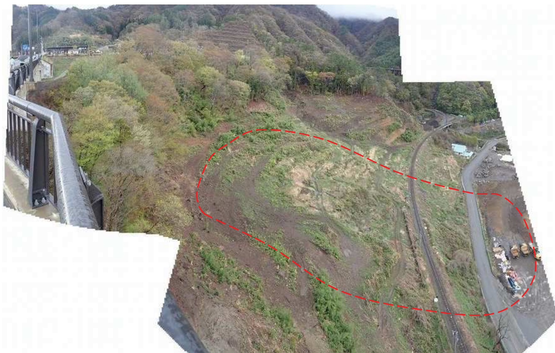
図 4.12 久森沢地区（L28）全景（湛水前状況：2019 年 9 月撮影）
