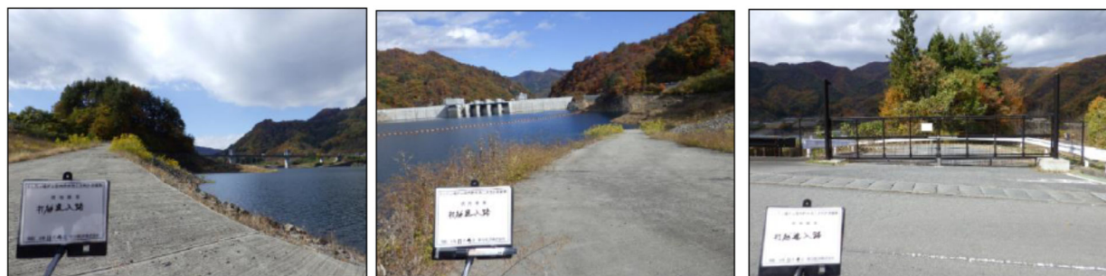
写真 3-1 打越進入路の状況（測量船搬入路）
